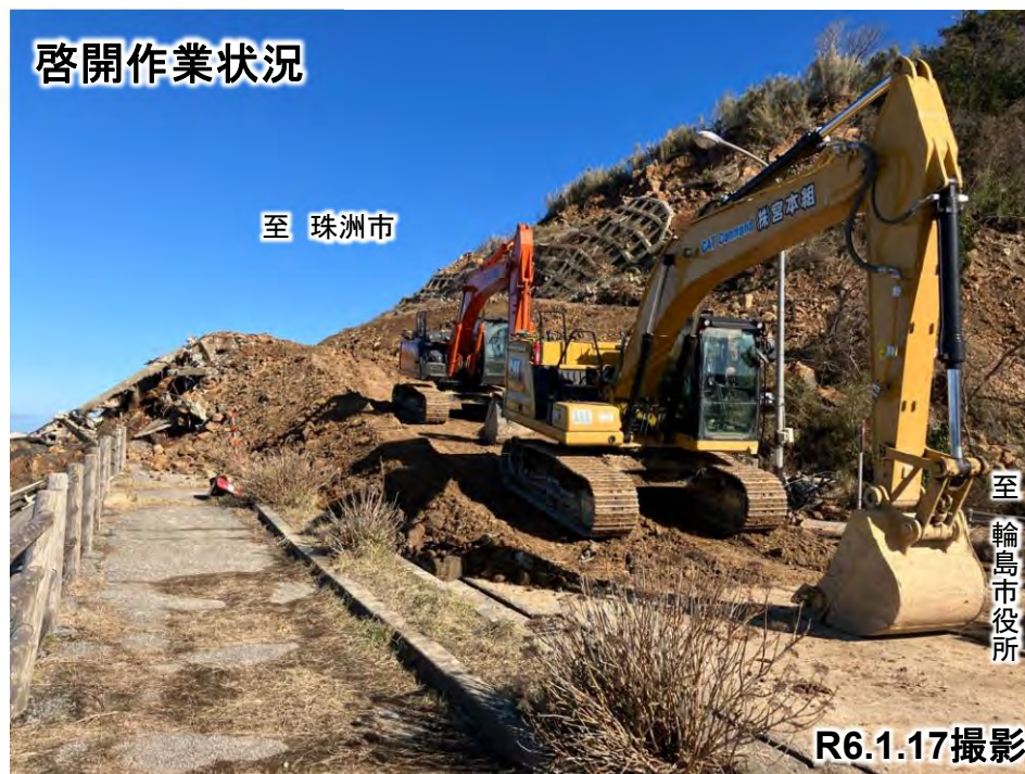
啓開作業状況
