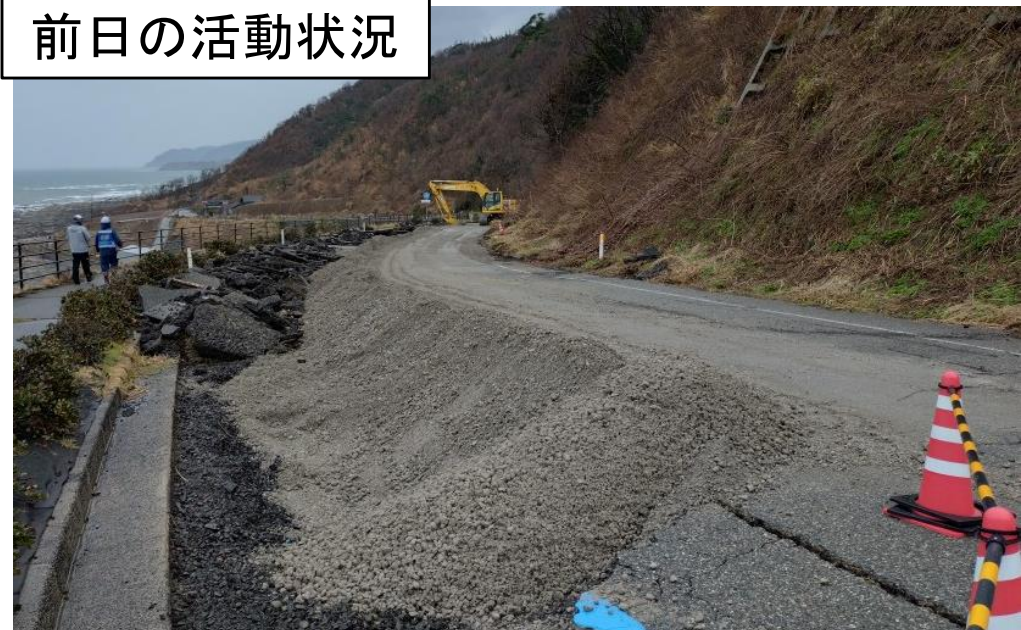
R249輪島市深見町付近 路面補修作業
