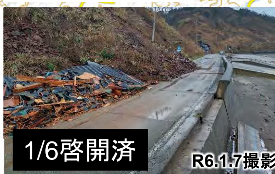
崩落箇所 啓開完了
