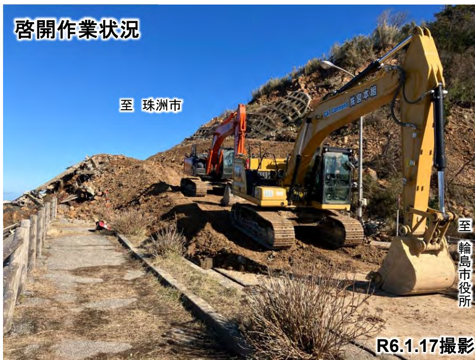
啓開作業状況
