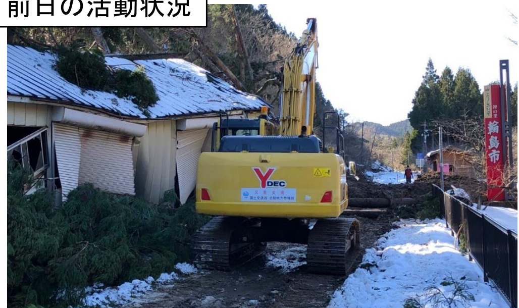
R249輪島市縄又町付近 路面補修作業
