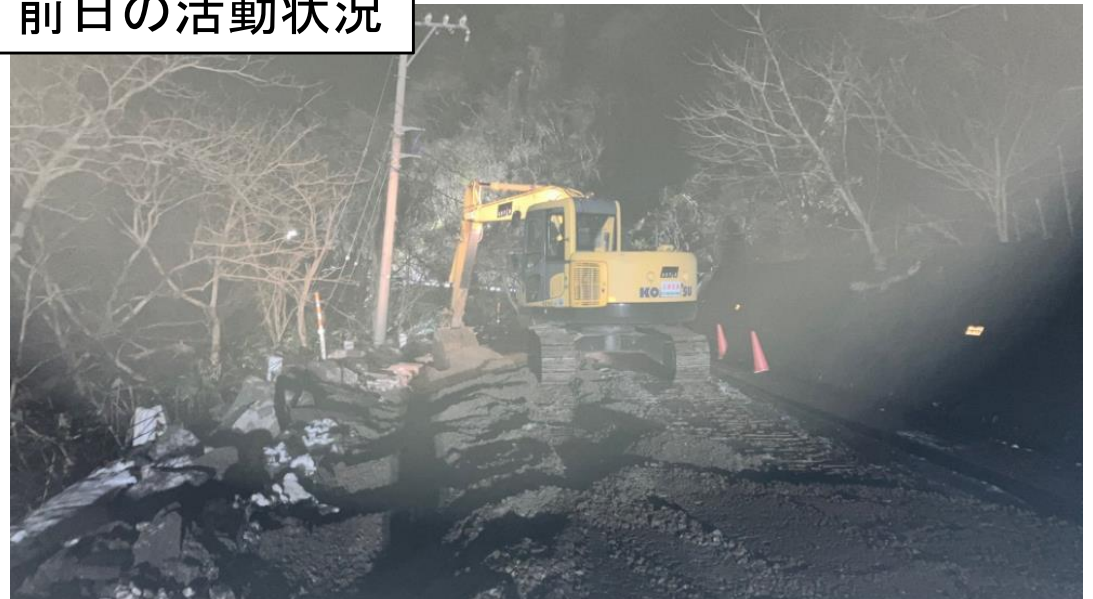
県道珠洲穴水線 珠洲市宝立町付近 路面補修作業
