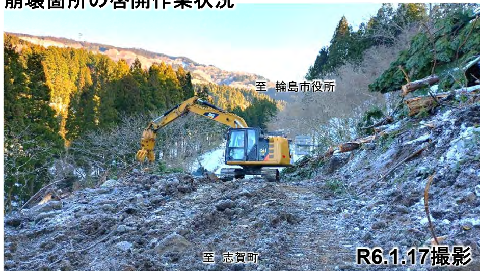
崩壊箇所の啓開作業状況
