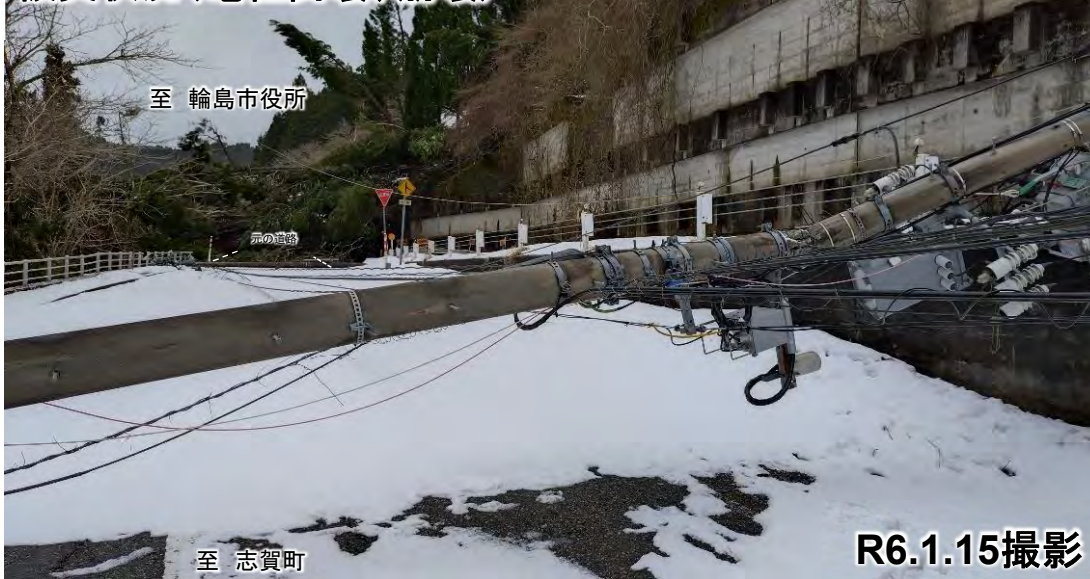
被災状況(電柱倒壊、崩壊)
