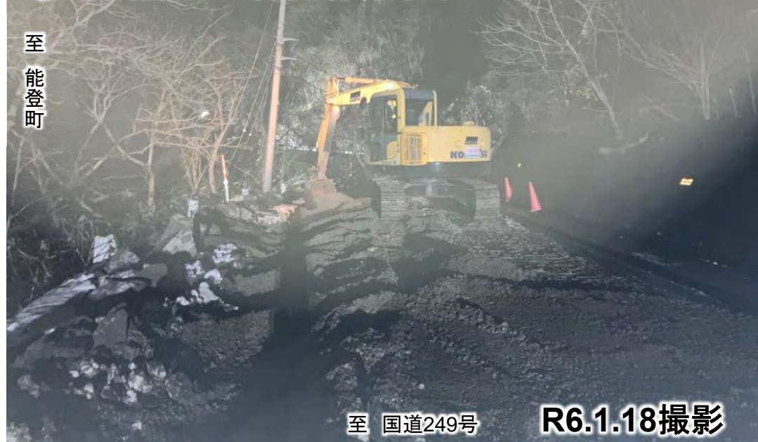
③ 亀裂箇所の啓開作業状況
