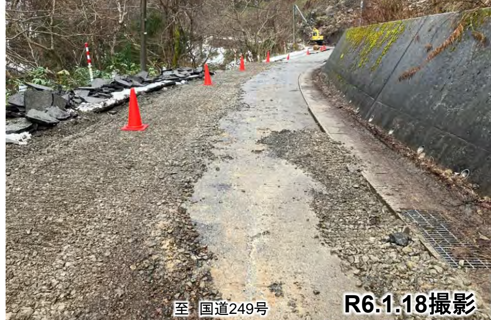
③ 亀裂箇所の啓開後の状況
