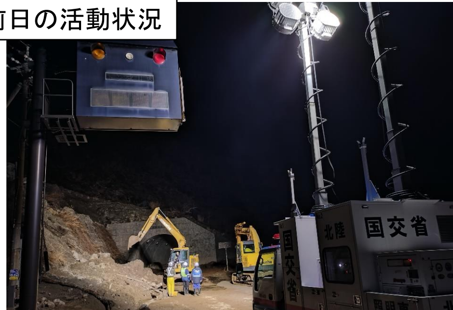
R249 八世乃洞門新トンネル付近 土砂撤去作業
