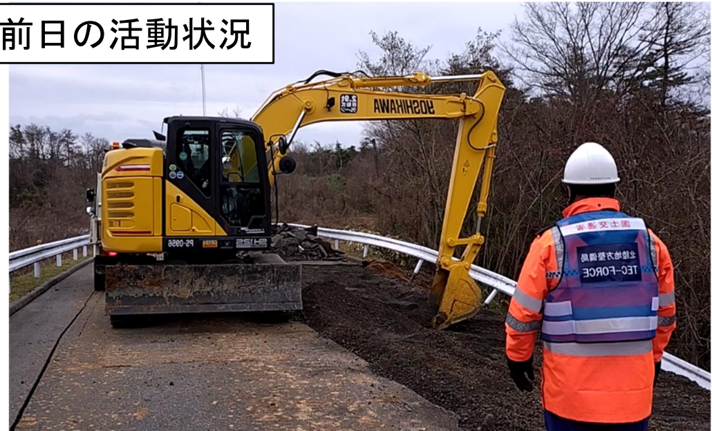
志賀町道鹿頭酒見線 志賀町鹿頭付近 路体撤去作業
