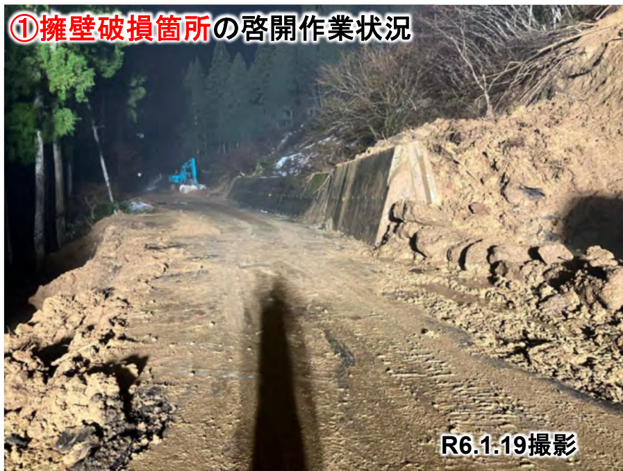
①擁壁破損箇所の啓開作業状況
