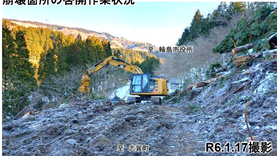
崩壊箇所の啓開作業状況
