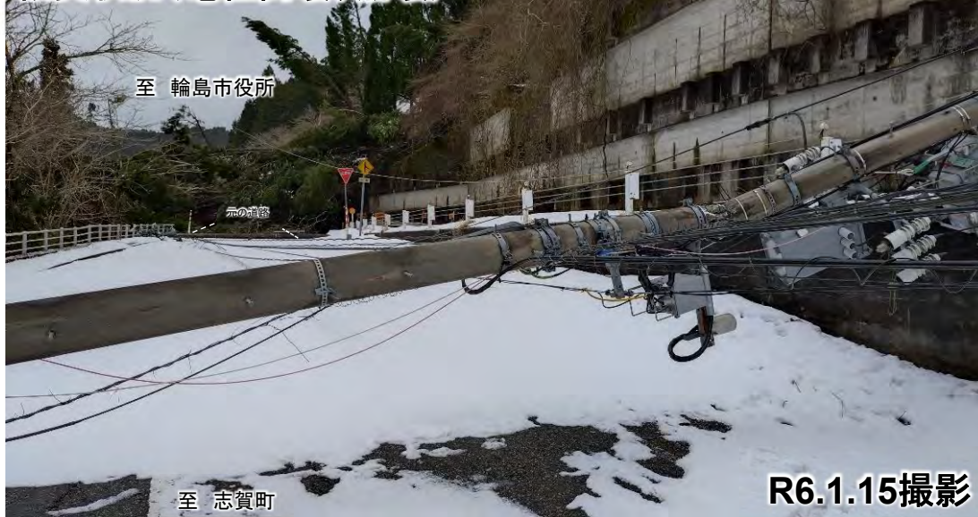
被災状況(電柱倒壊、崩壊)
