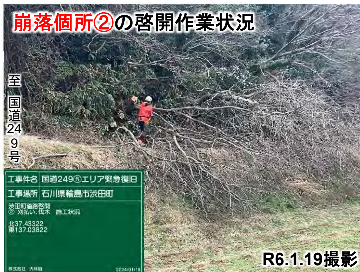
崩落箇所②の啓開作業状況
