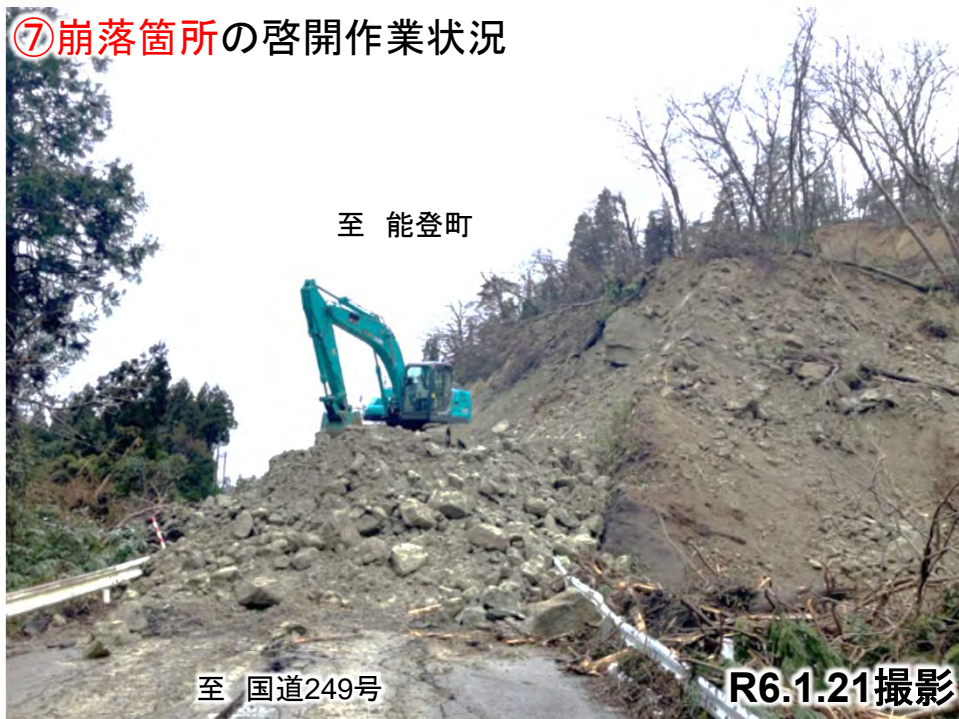
⑦崩落箇所への啓開作業状況
