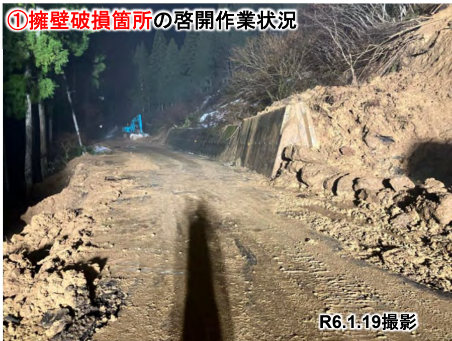
①擁壁破損箇所への啓開作業状況
