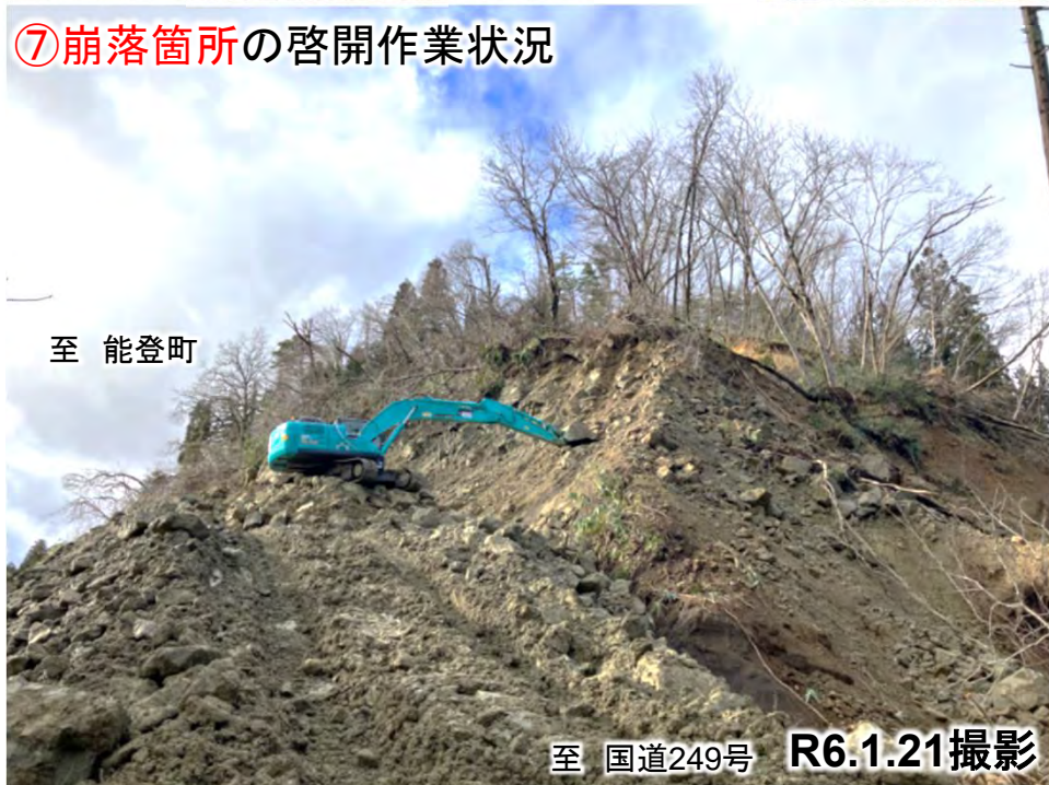
⑦崩落箇所への啓開作業状況
