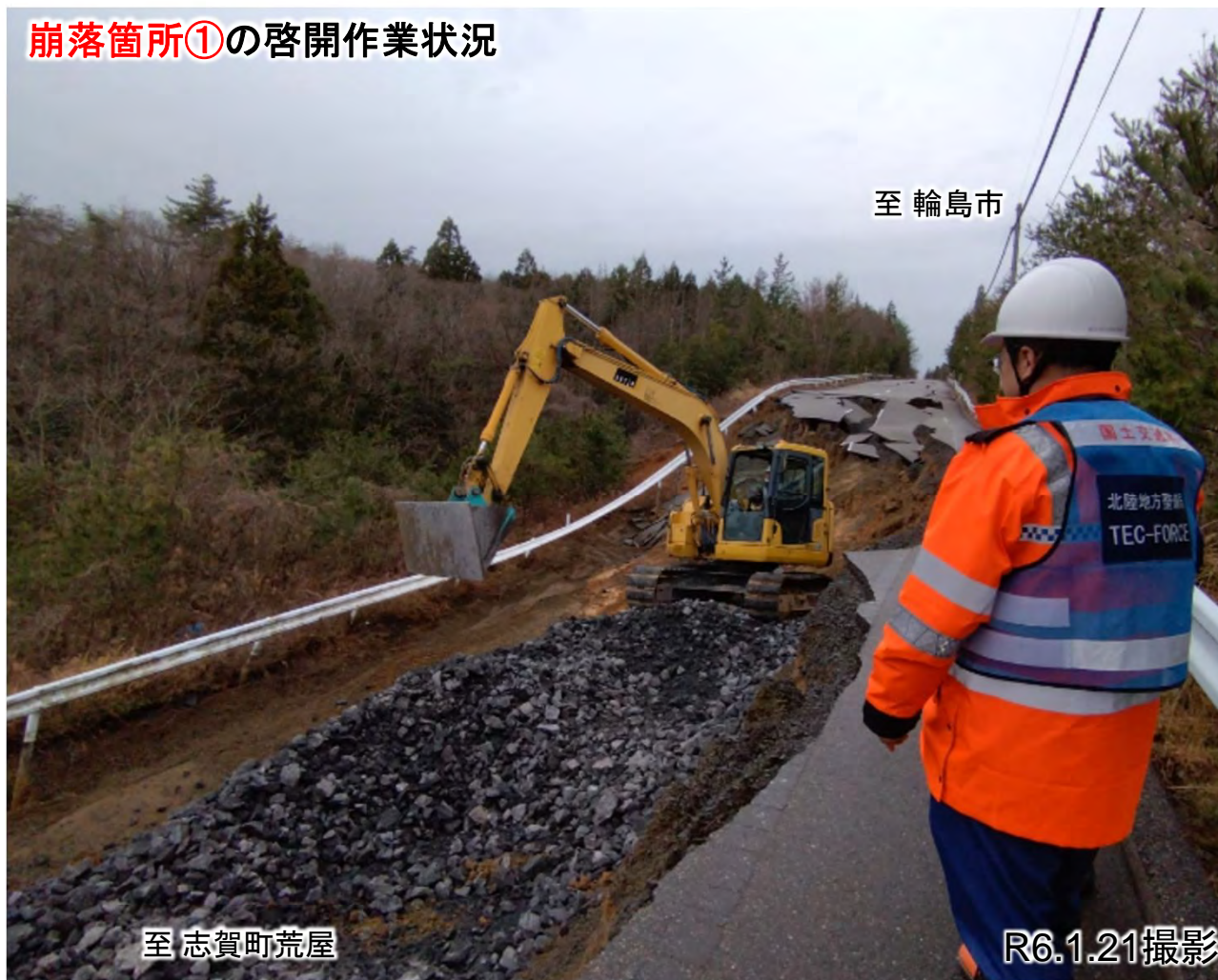
崩落箇所①の啓開作業状況
