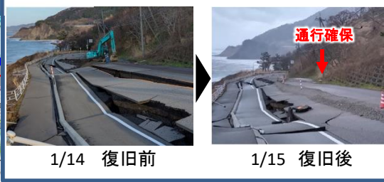
写真③ 国道249号緊急復旧完了
