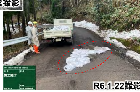
舗装損傷箇所を啓開状況
