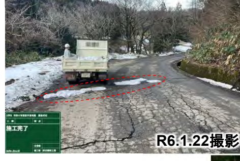
舗装損傷箇所を啓開状況
