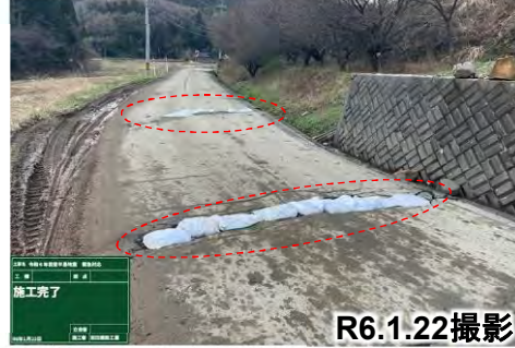
舗装損傷箇所を啓開状況
