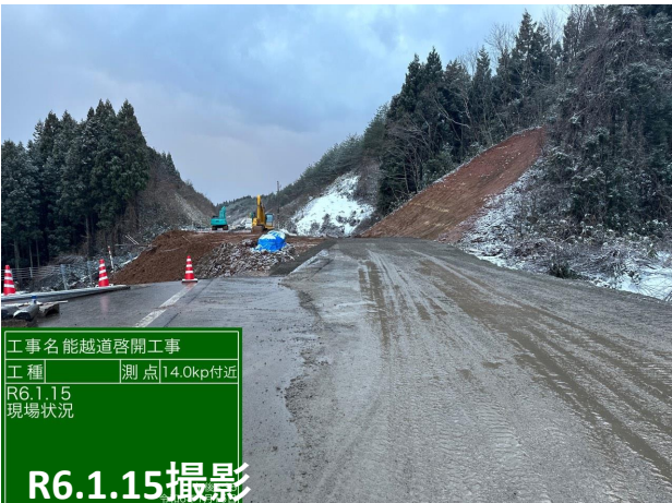
No.16 法面切土
