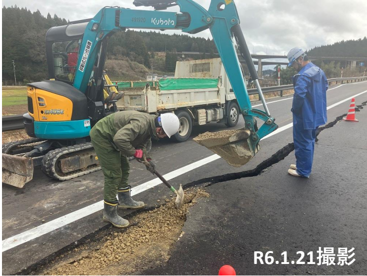
穴水ICアクセス路 段差復旧状況
