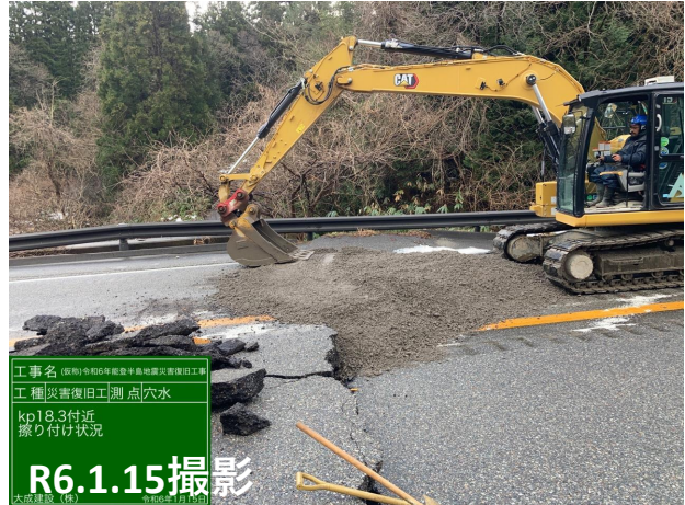
No.56 段差擦り付け
