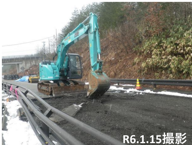
No.6段差復旧状況
