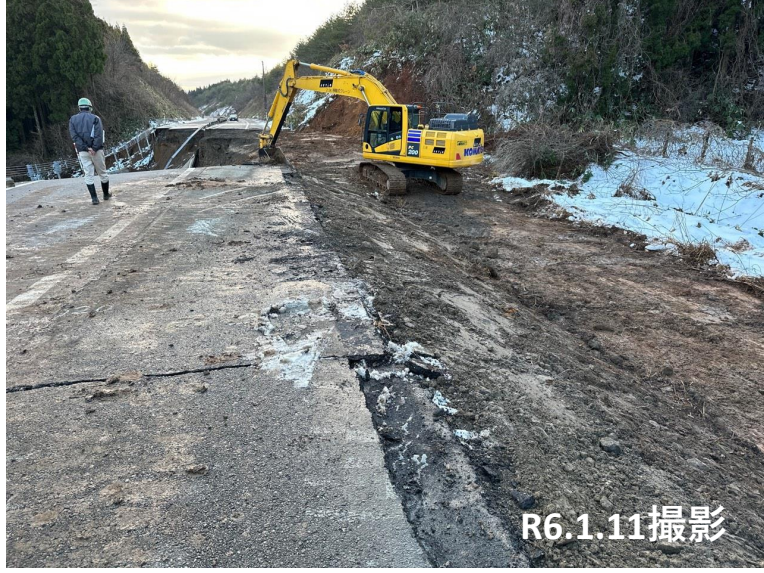
No.16 碎石充填状況
