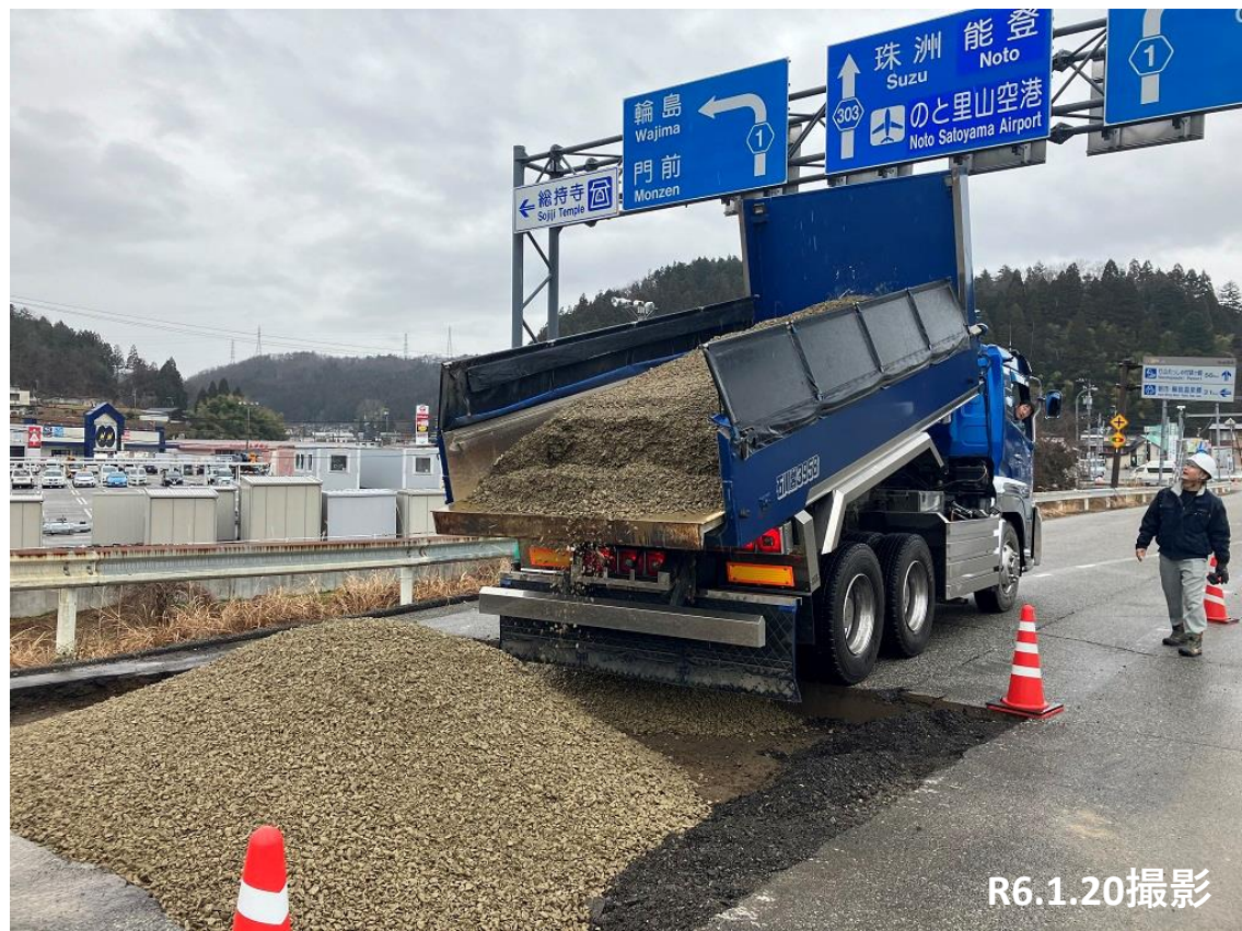
穴水ICアクセス路 段差復旧状況
