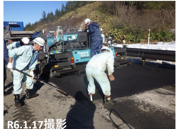
No.6 段差復旧状況
