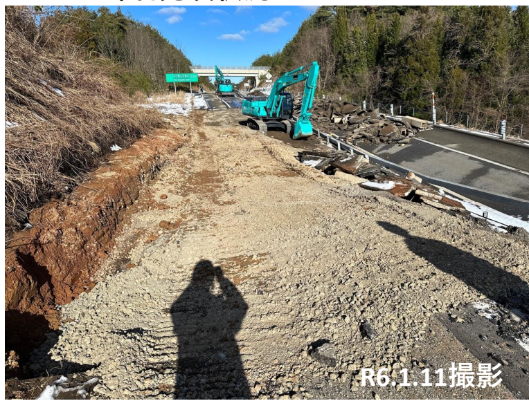
No.15 碎石充填状況
