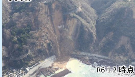
写真④ 国道249号法面崩落
