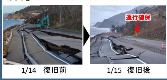
写真③ 国道249号緊急復旧完了
