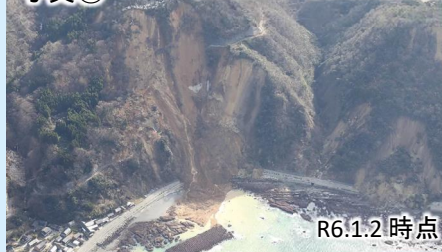
写真④ 国道249号法面崩落
