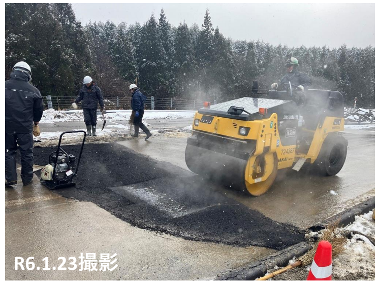
No41～42 舗装・段差復旧状況
