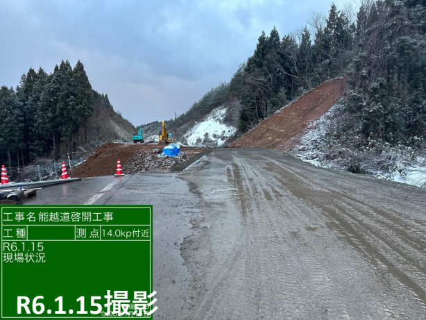
No.16 法面切土
