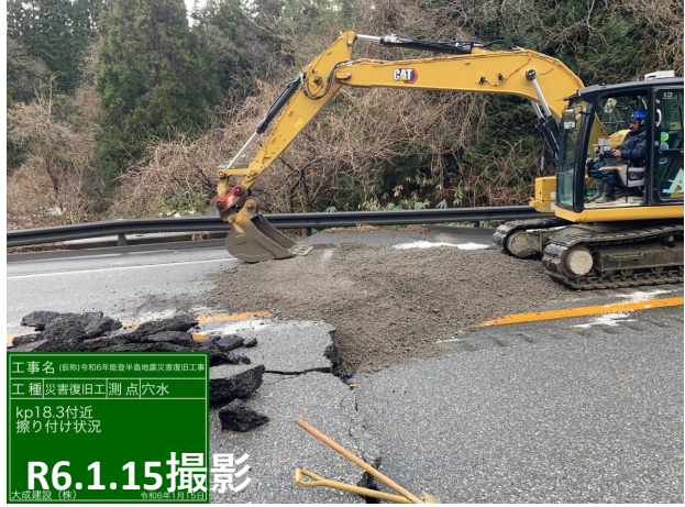
No.56 段差擦り付け
