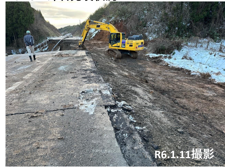
No.16 碎石充填状況
