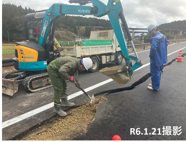
No41～42 段差復旧状況
