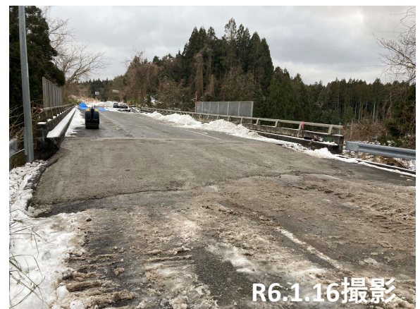
No.51 段差擦り付け
