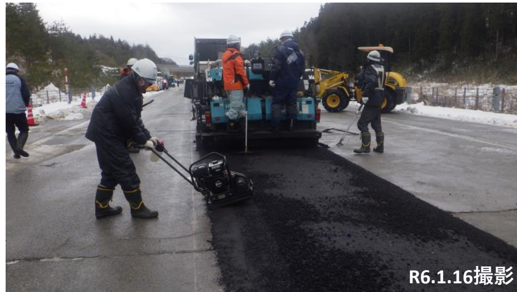
No.6 路面亀裂、段差復旧状況
