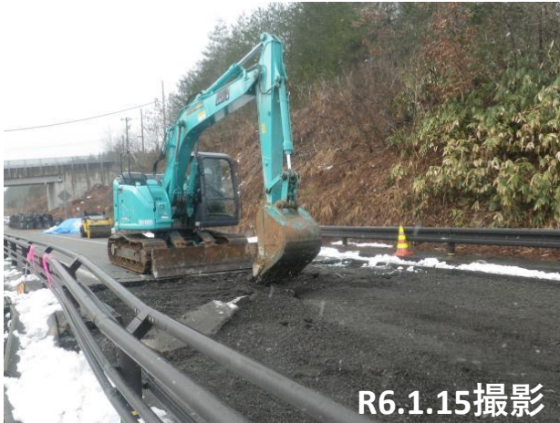
No.6段差復旧状況
