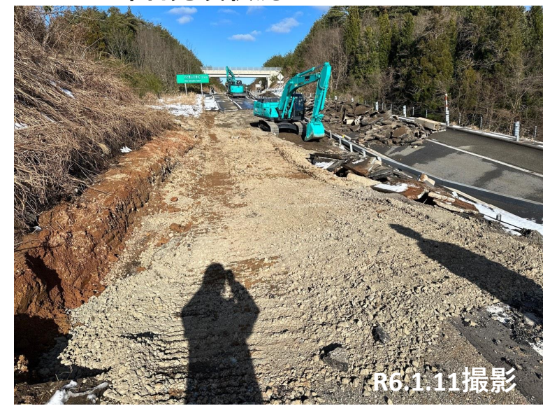
No.15 碎石充填状況
