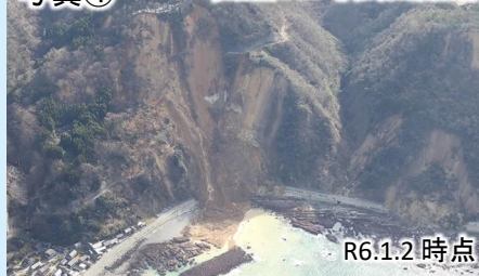
写真④ 国道249号法面崩落
