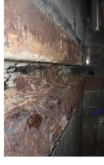
構造目地の腐食・漏水 中床版上面のコンクリートはく離
