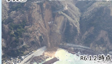
写真④ 国道249号法面崩落
