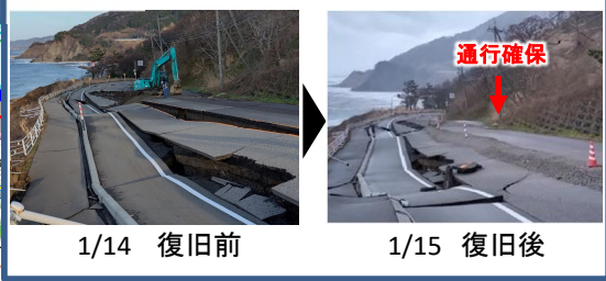
写真③ 国道249号緊急復旧完了
