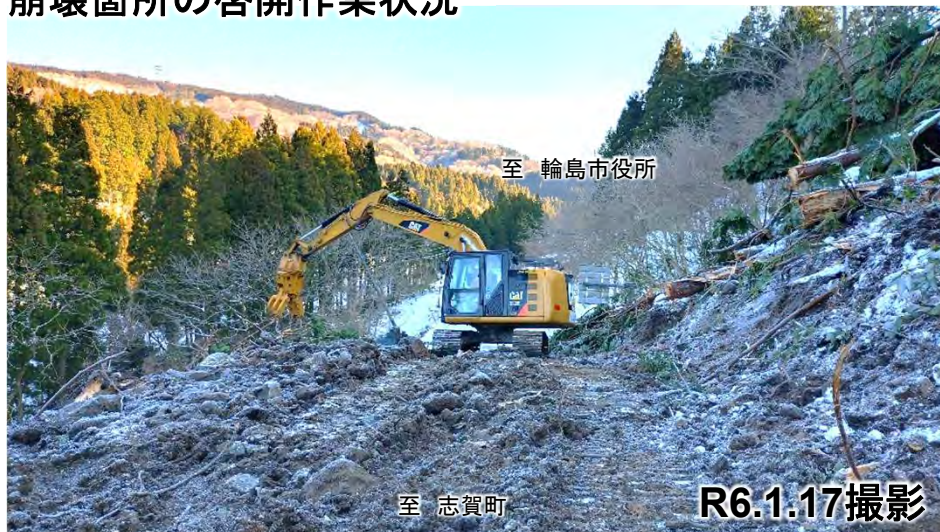
崩壊箇所の啓開作業状況
