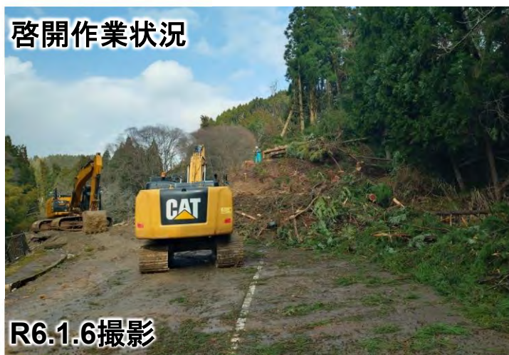
啓開作業状況
