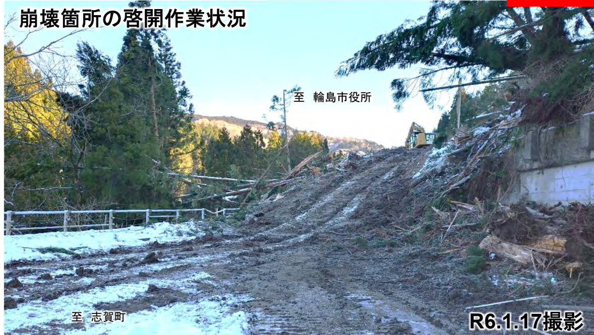
崩壊箇所の啓開作業状況
