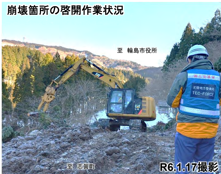
崩壊箇所の啓開作業状況
