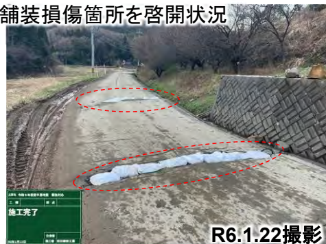
舗装損傷箇所を啓開状況
