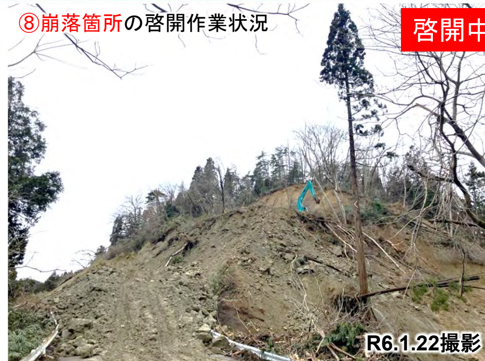
⑧崩落箇所の啓開作業状況
