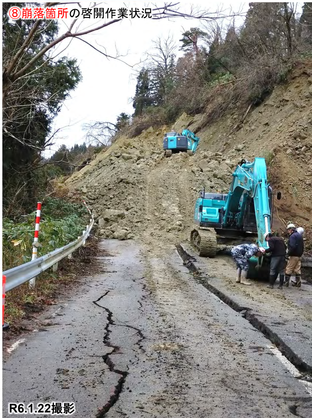
⑧崩落箇所の啓開作業状況
