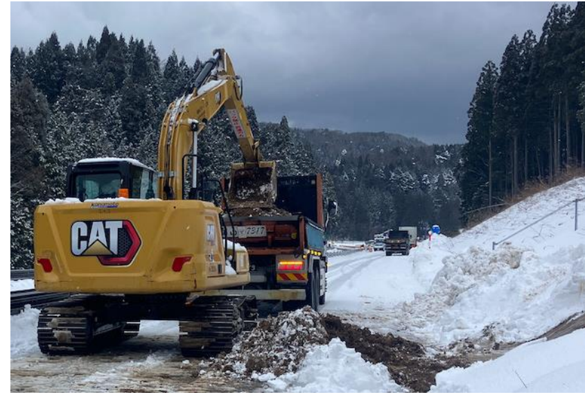
No.3 土砂積込運搬状況
