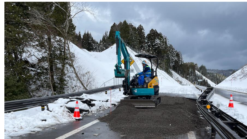
No.7 路面補修状況
