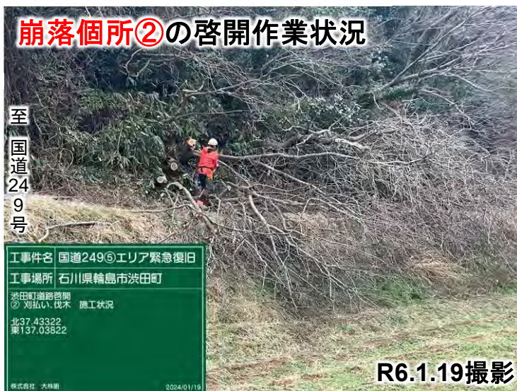
崩落箇所②の啓開作業状況
