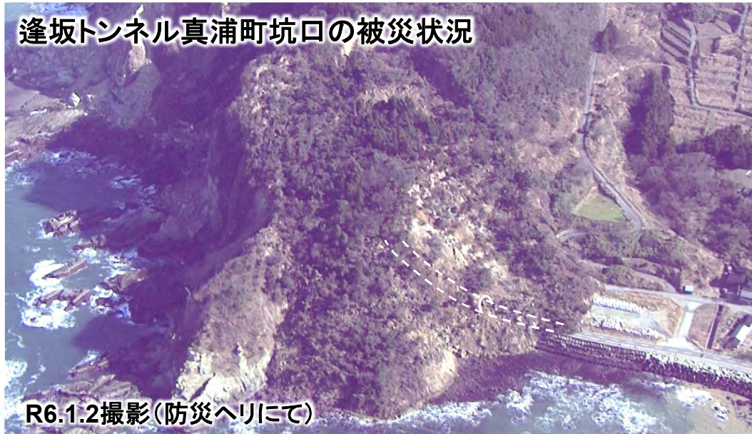
逢坂トンネル真浦町坑口の被災状況
