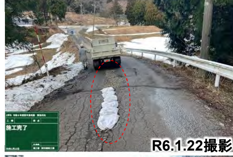
舗装損傷箇所を啓開状況
