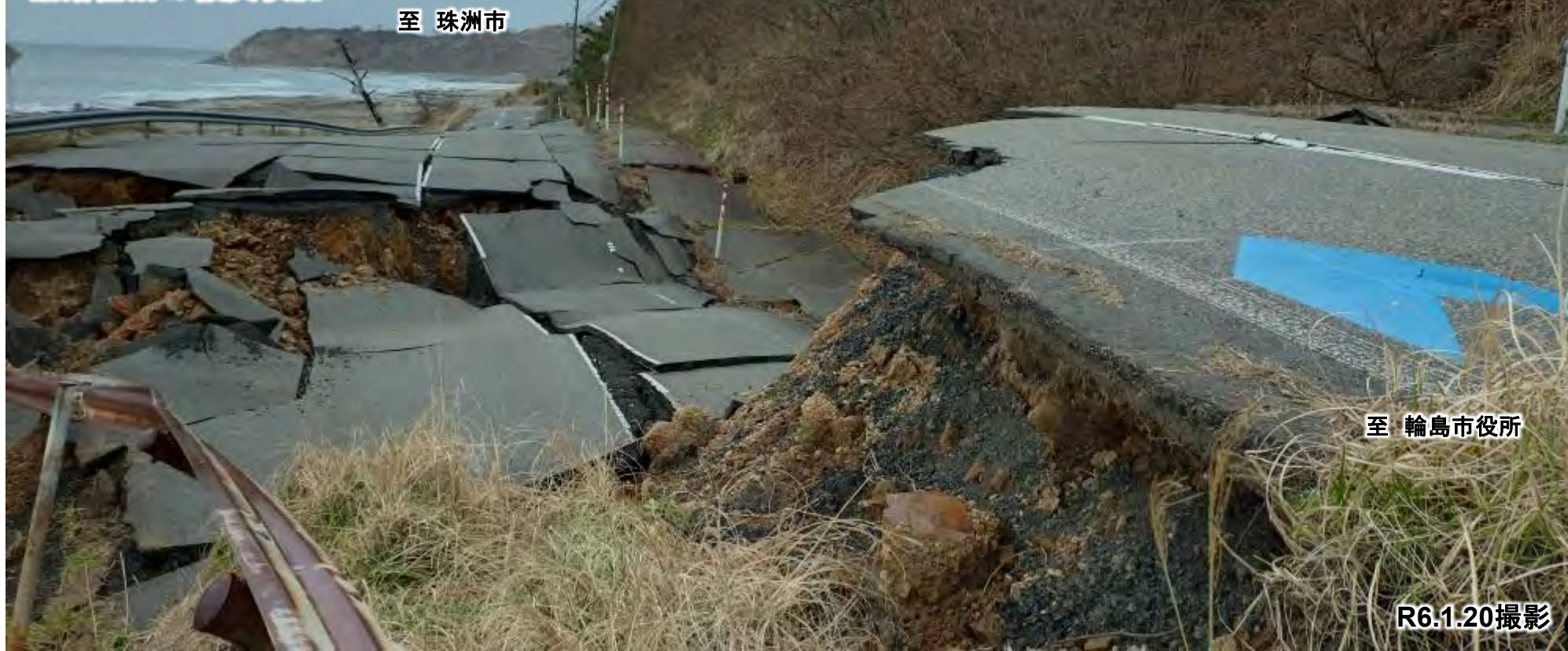
崩落箇所の被災状況
