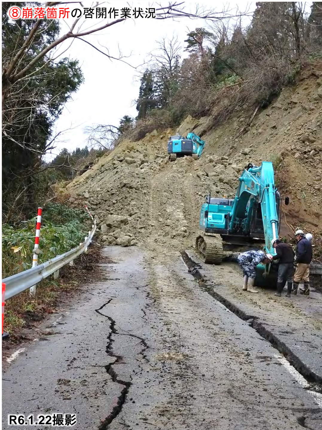
⑧崩落箇所の啓開作業状況
