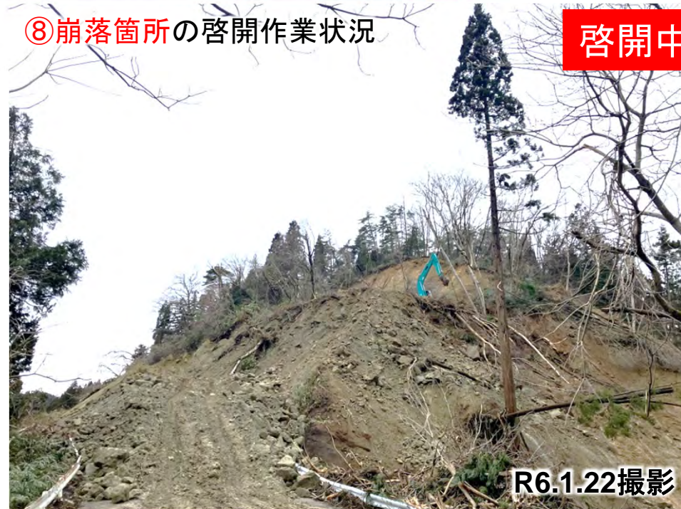
⑧崩落箇所の啓開作業状況
