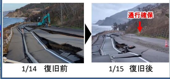
写真③ 国道249号緊急復旧完了
