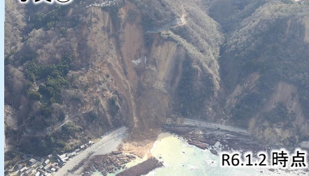
写真④ 国道249号法面崩落
