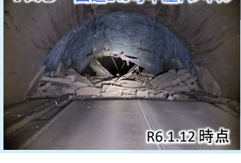
写真① 国道249号中屋トンネル
