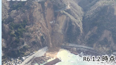
写真③ 国道249号法面崩落
