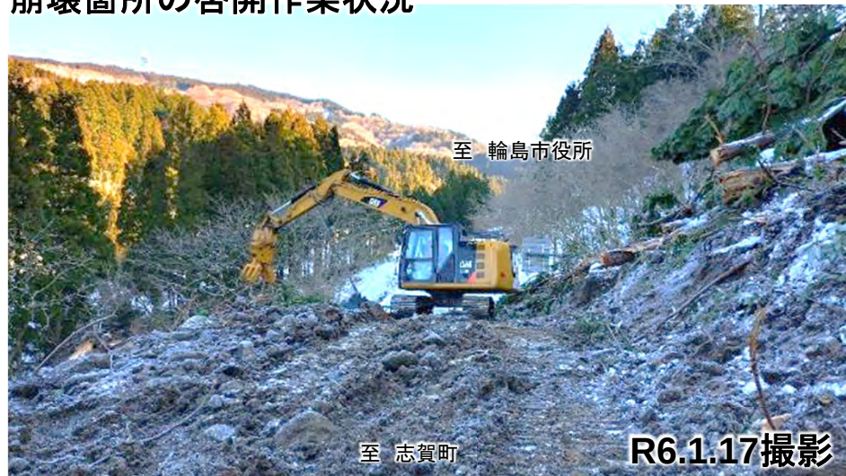
崩壊箇所の啓開作業状況
