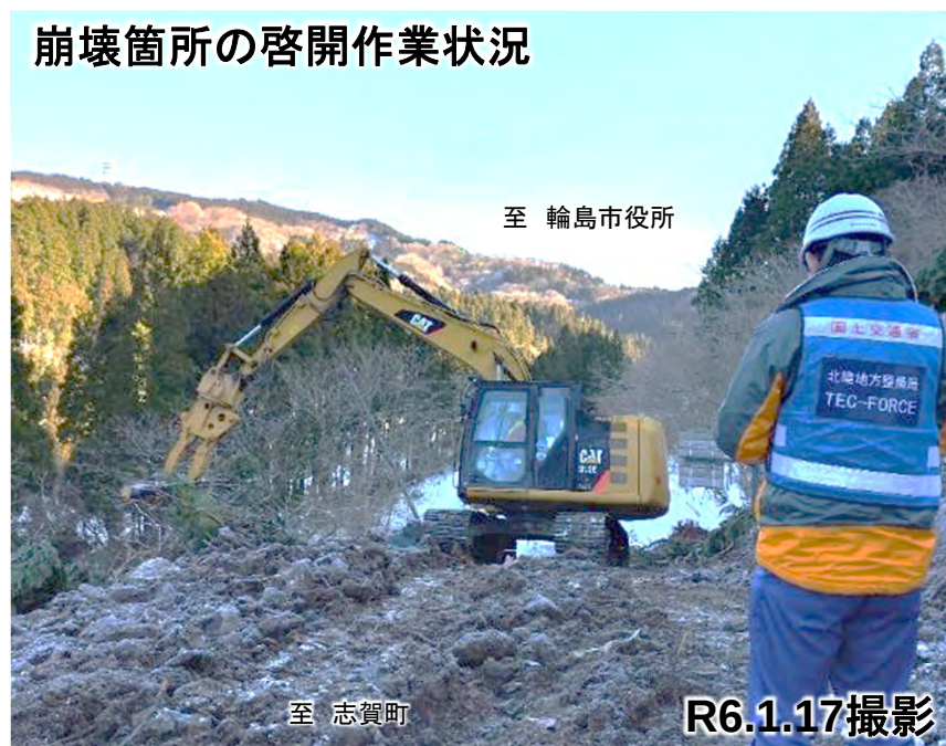
崩壊箇所の啓開作業状況
