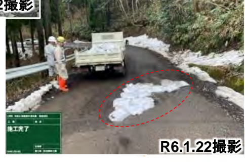
舗装損傷箇所を啓開状況
