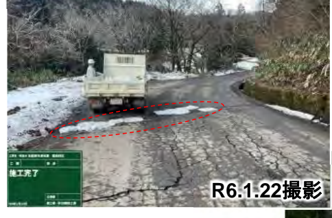
舗装損傷箇所を啓開状況
