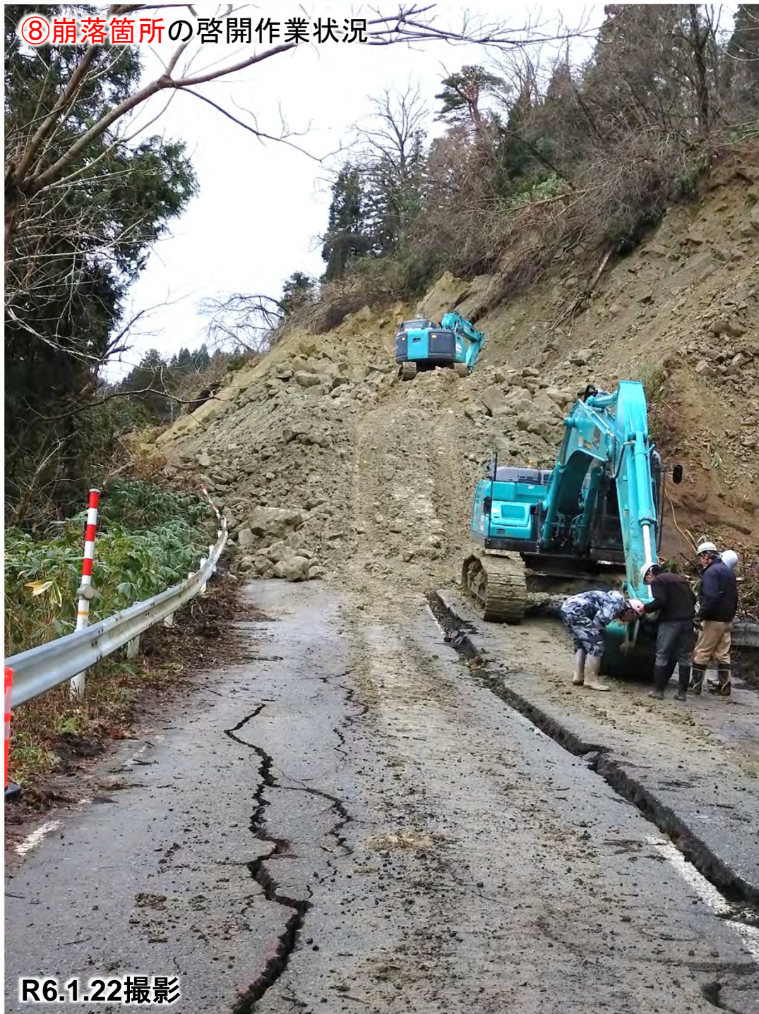
⑧崩落箇所の啓開作業状況
