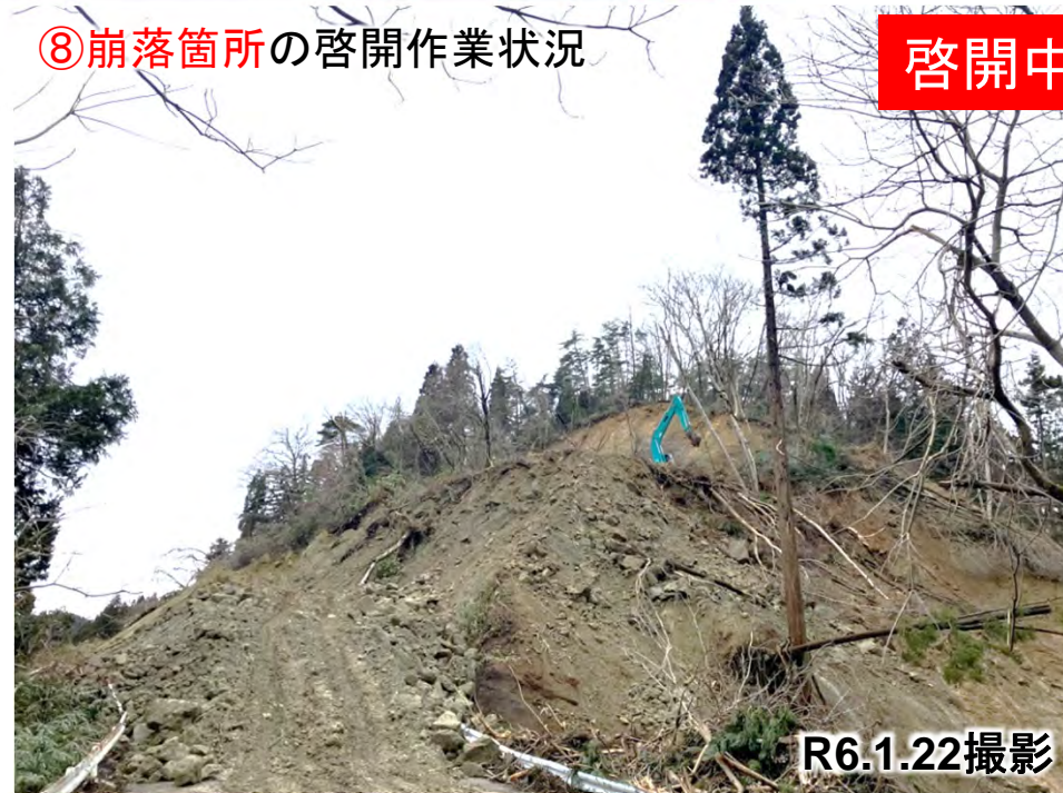
⑧崩落箇所の啓開作業状況
