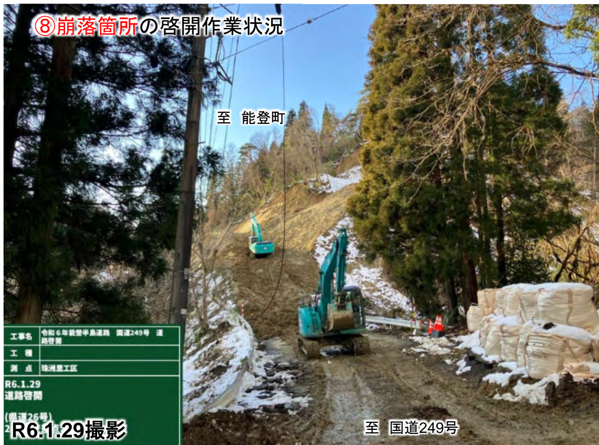
⑧崩落箇所への啓開作業状況
