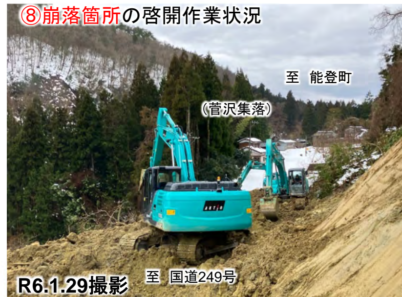
⑧崩落箇所への啓開作業状況
