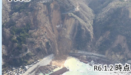
写真③ 国道249号法面崩落
