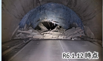
写真① 国道249号中屋トンネル
