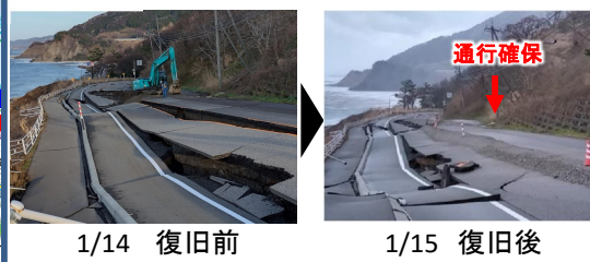
写真② 国道249号緊急復旧完了
