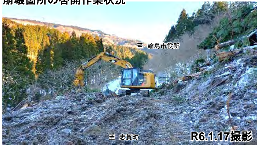
崩壊箇所の啓開作業状況
