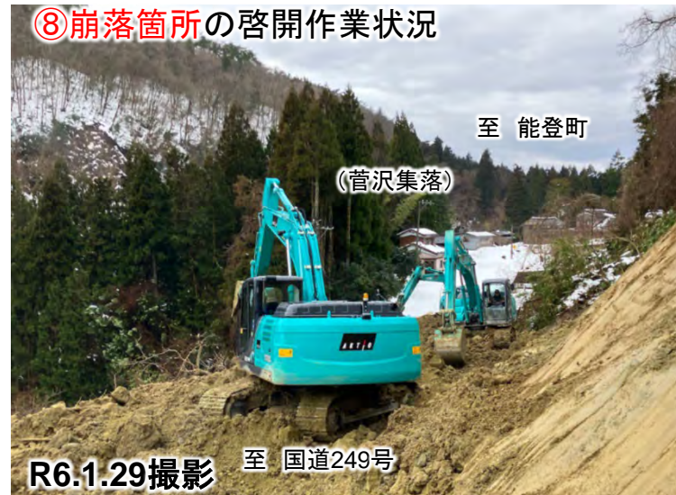
⑧崩落箇所の啓開作業状況
