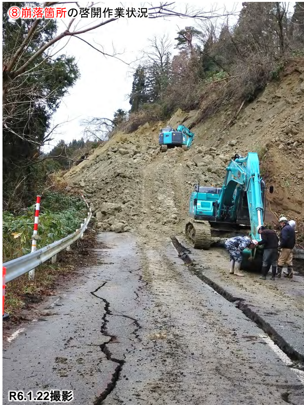
⑧崩落箇所への啓開作業状況
