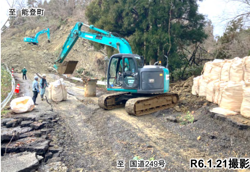
⑧崩落箇所の啓開作業状況
