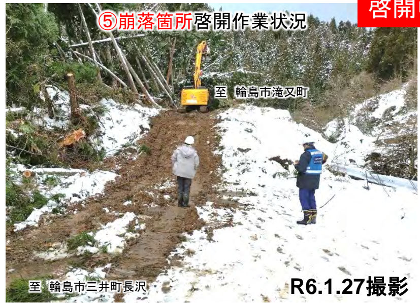
⑤崩落箇所啓開作業状況
