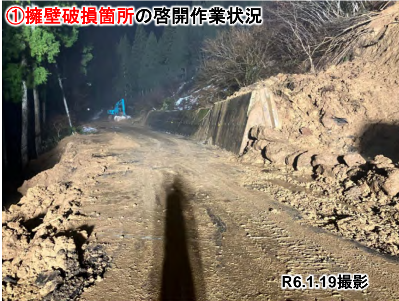
①擁壁破損箇所の啓開作業状況
