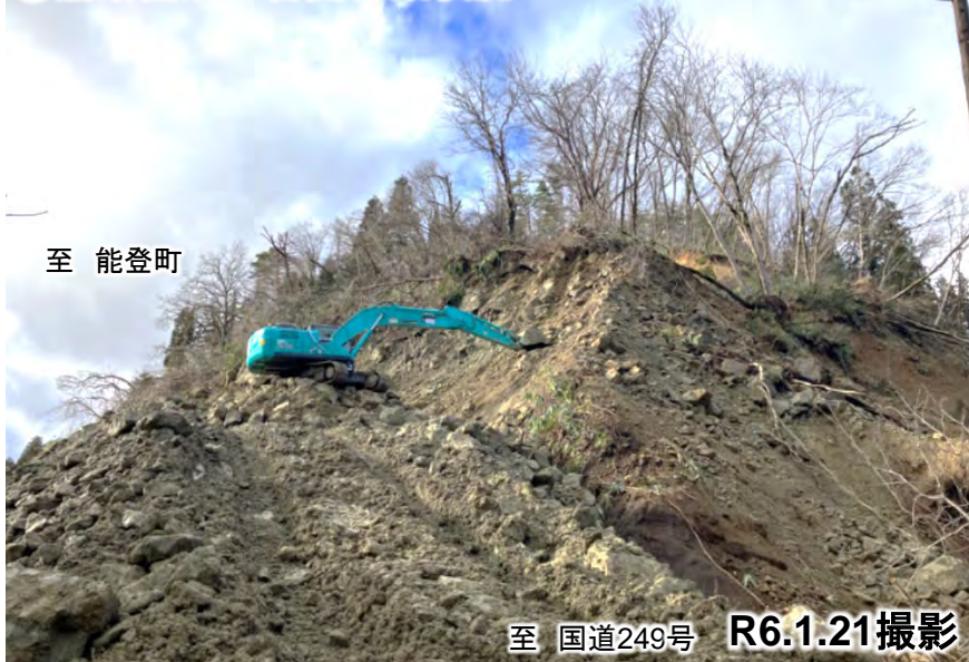
⑧崩落箇所の啓開作業状況
