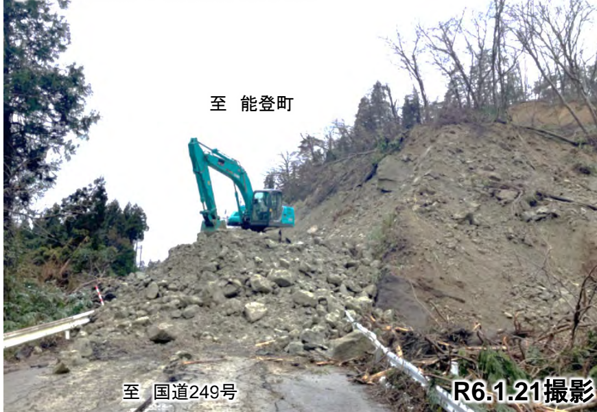
⑧崩落箇所の啓開作業状況
