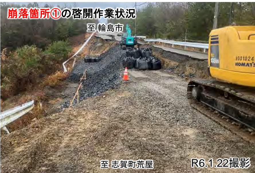
崩落箇所①の啓開作業状況
