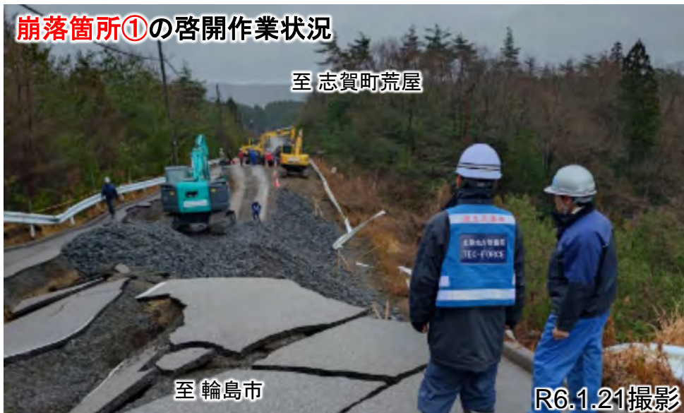
崩落箇所①の啓開作業状況
