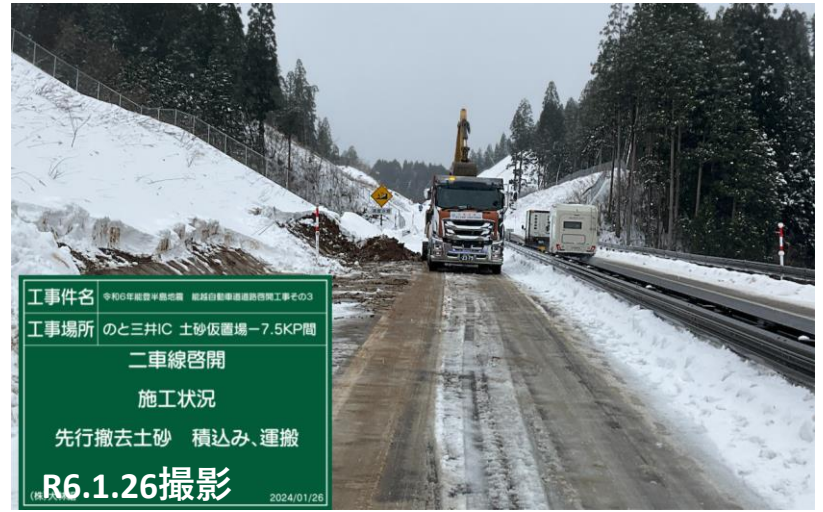
No.3土砂積込運搬状況
