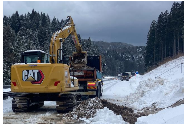
No.3 土砂積込運搬状況
