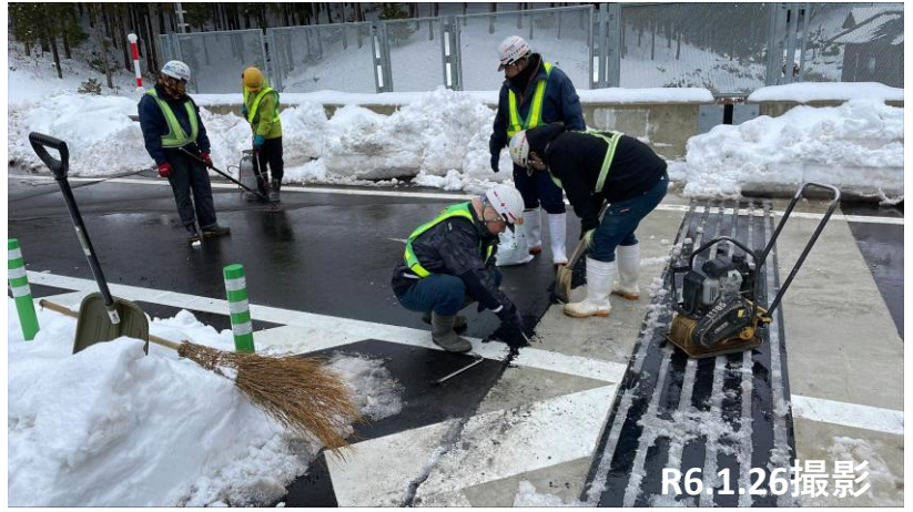
No.26 段差補修状況
