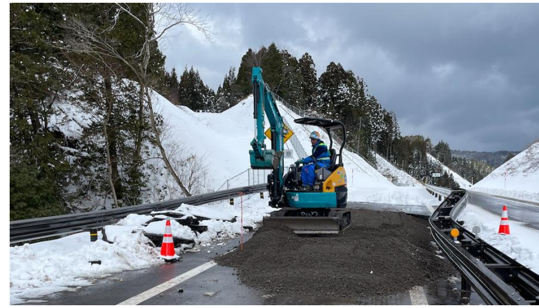
No.7 路面補修状況
