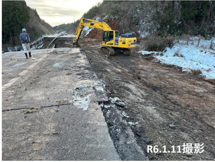
No.16 碎石充填状況
