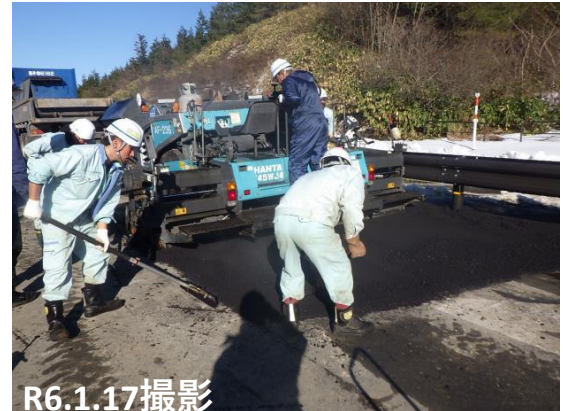
No.6 段差復旧状況
