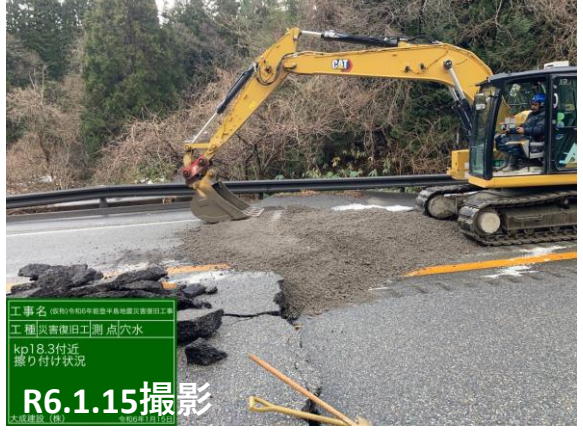
No.56 段差擦り付け
