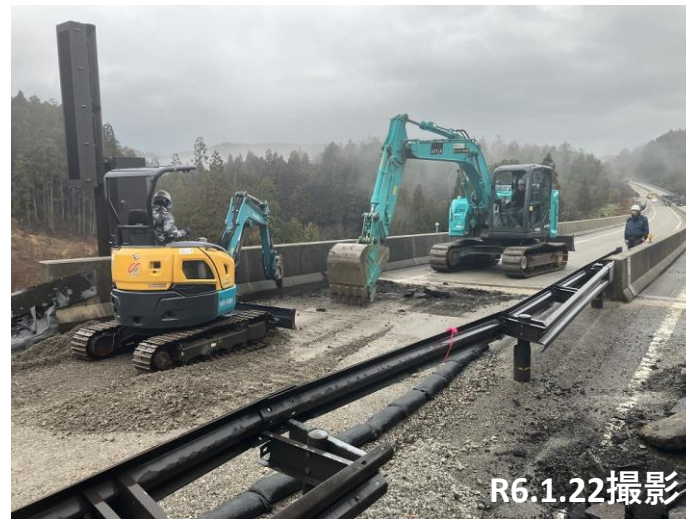
No41～42 段差復旧状況
