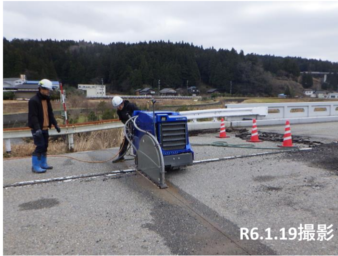
No.6 段差復旧状況
