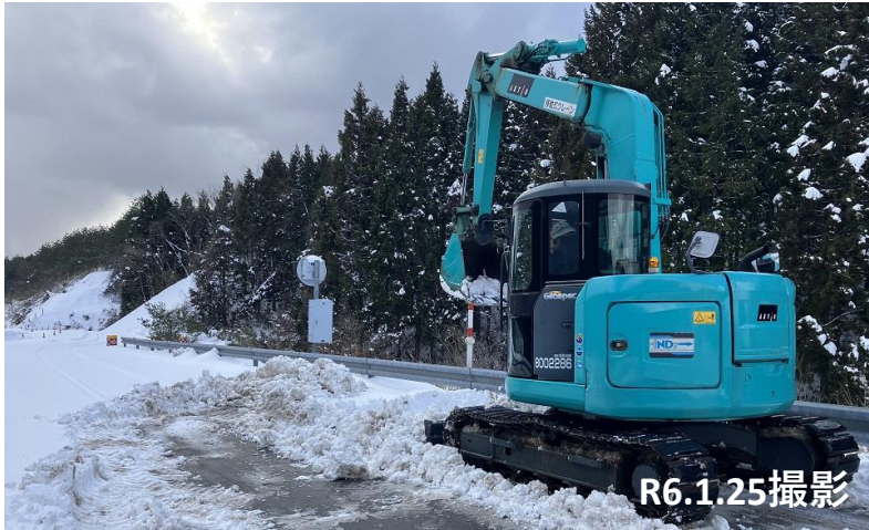
復旧箇所の除雪状況
