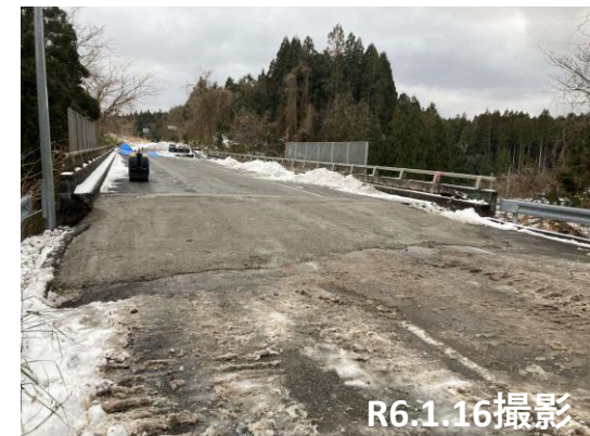
No.51 段差擦り付け
