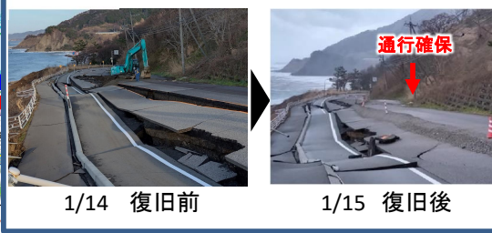
写真② 国道249号緊急復旧完了
