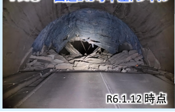
写真① 国道249号中屋トンネル
