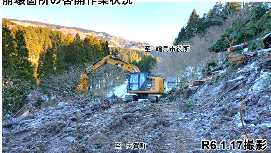
崩壊箇所の啓開作業状況
