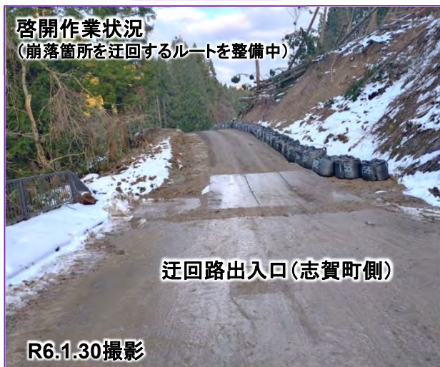
啓開作業状況 (崩落箇所を迂回するルートを整備中)
