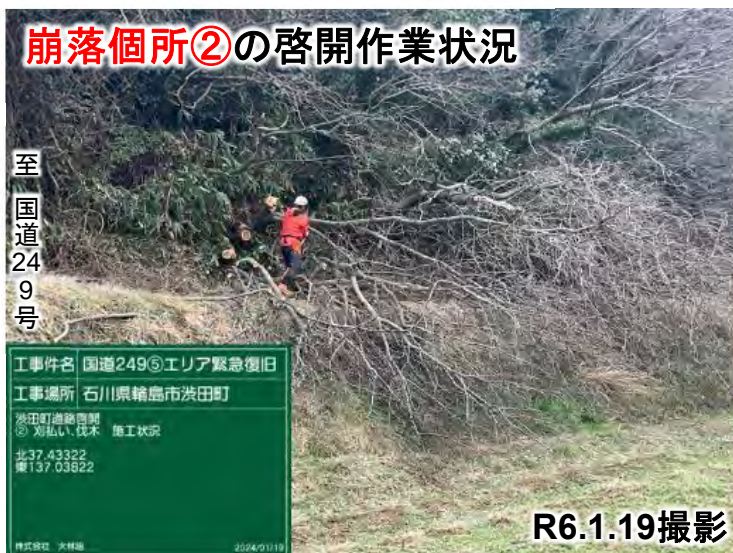
崩落箇所②の啓開作業状況
