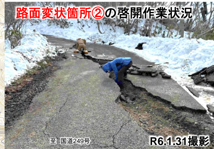
路面変状箇所②の啓開作業状況
