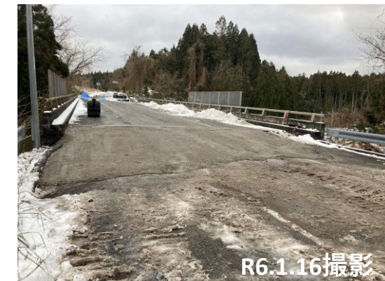
No.51 段差擦り付け
