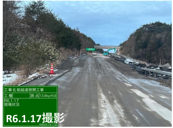
No.15 碎石埋戻し状況
