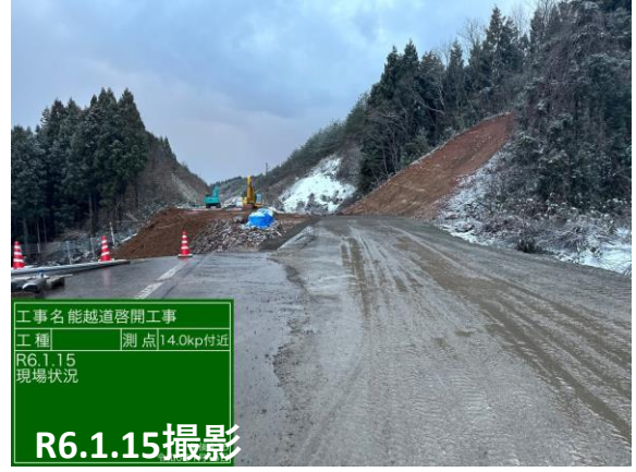
No.16 法面切土
