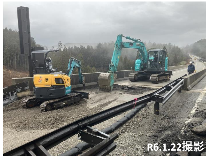
No41～42 段差復旧状況
