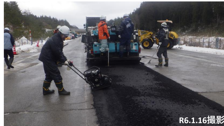
No.6 路面亀裂、段差復旧状況
