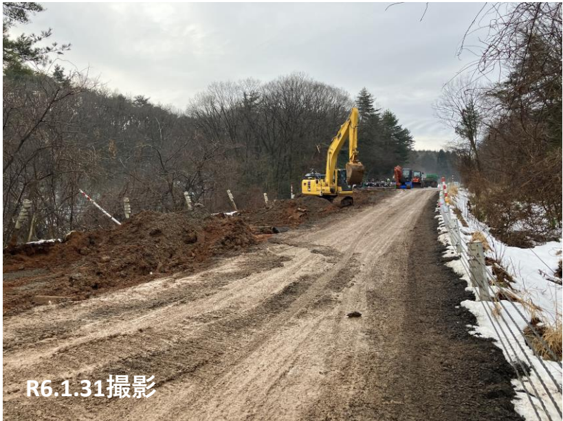
No.40路盤造成状況
