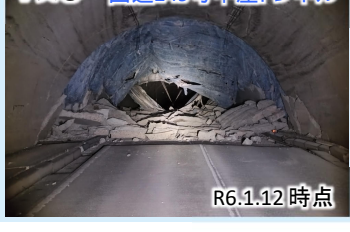
写真① 国道249号中屋トンネル
