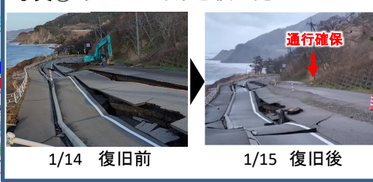
写真② 国道249号緊急復旧完了
