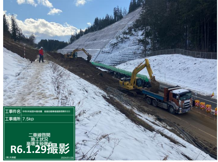
No.3 土砂掘削及び積込状況
