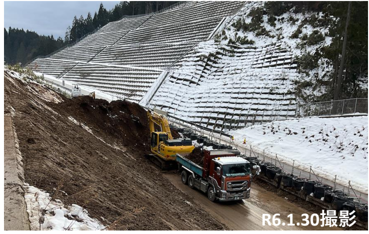
No.3 土砂掘削及び積込状況
