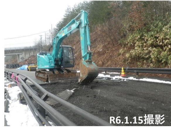
No.6段差復旧状況
