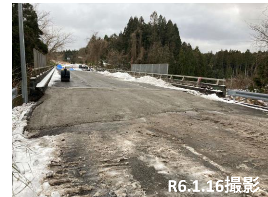
No.51 段差擦り付け
