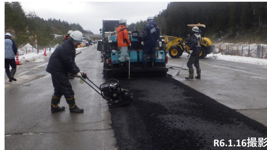
No.6 路面亀裂、段差復旧状況
