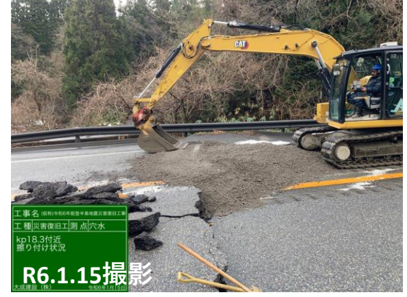
No.56 段差擦り付け
