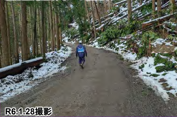
啓開作業状況 (崩落箇所を迂回するルートを整備中)
