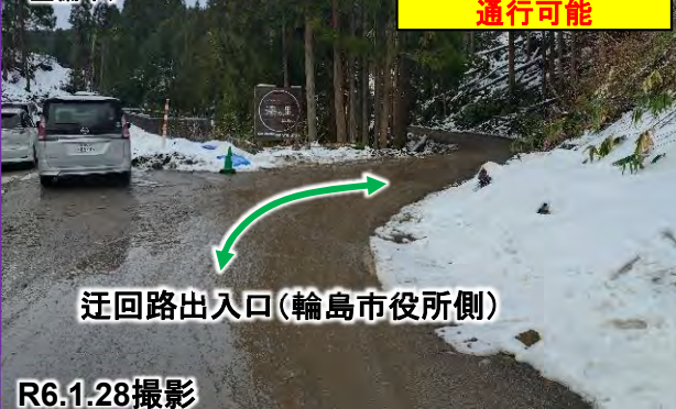
啓開作業状況 (崩落箇所を迂回するルートを整備中)
