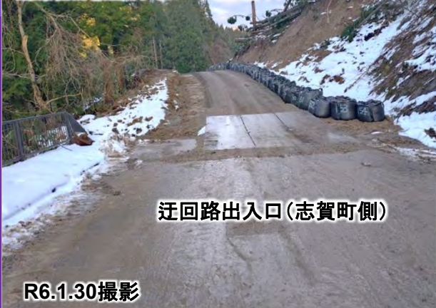
啓開作業状況 (崩落箇所を迂回するルートを整備中)
