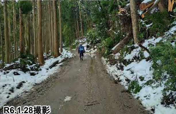
啓開作業状況 (崩落箇所を迂回するルートを整備中)
