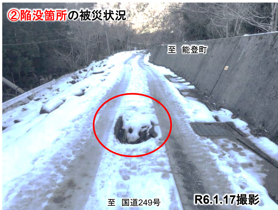
②陥没箇所の啓開後の状況
