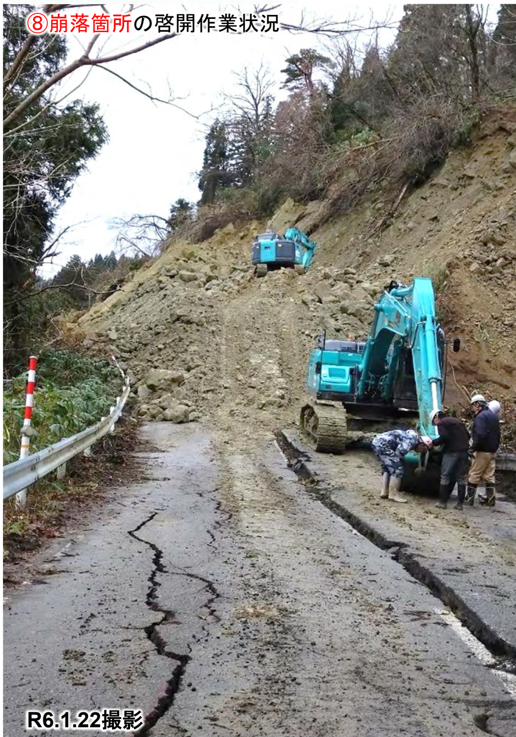
⑧崩落箇所の啓開作業状況
