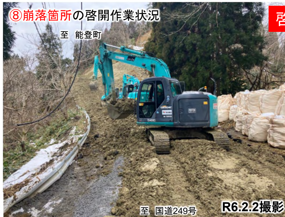
⑧崩落箇所への啓開作業状況
