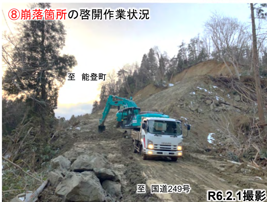
⑧崩落箇所への啓開作業状況
