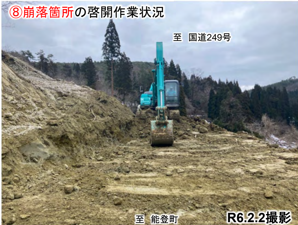
⑧崩落箇所への啓開作業状況
