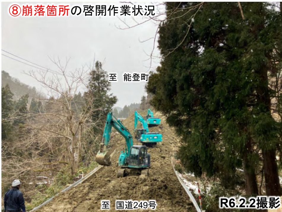
⑧崩落箇所への啓開作業状況
