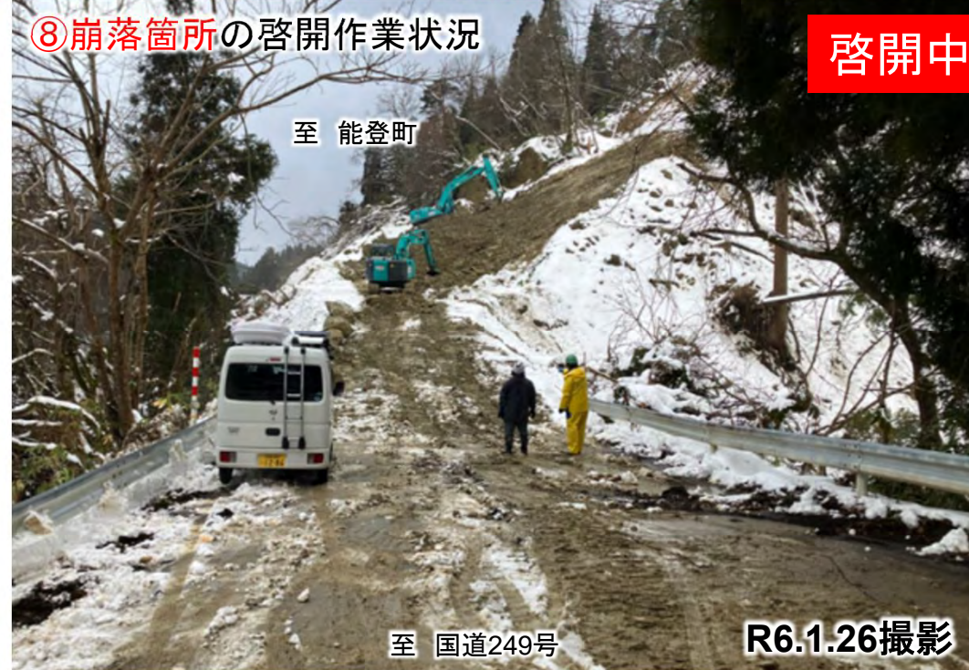
⑧崩落箇所の啓開作業状況
