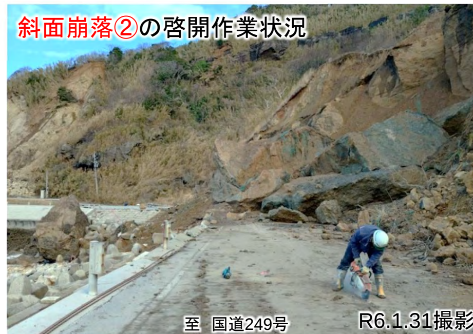
斜面崩落②の啓開作業状況
