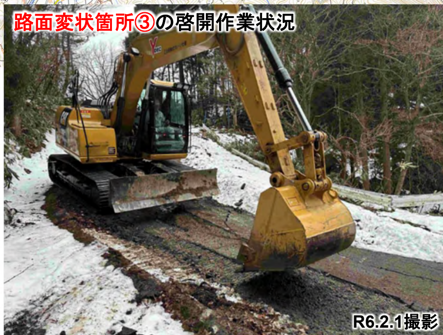
路面変状箇所③の啓開作業状況
