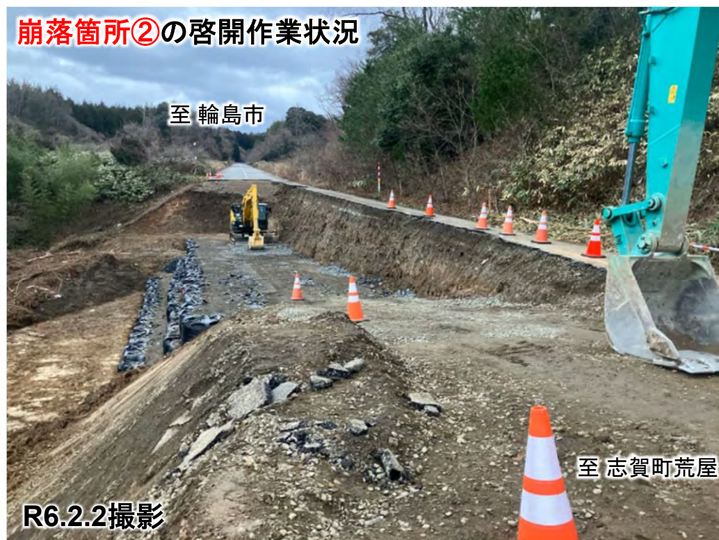
崩落箇所②の啓開作業状況
