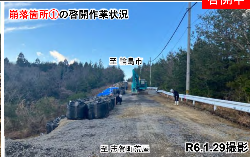
崩落箇所①の啓開作業状況
