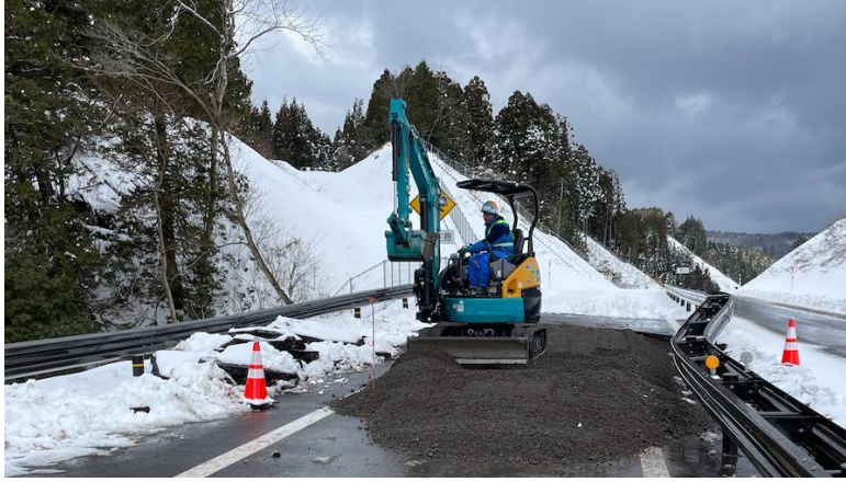
No.7 路面補修状況
